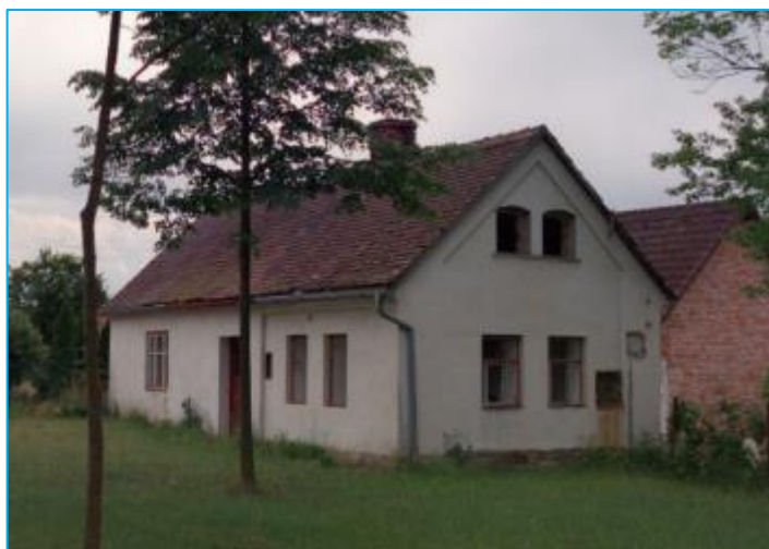
Obrázek 5 Objekt Bolehošť čp. 86 – exteriér
